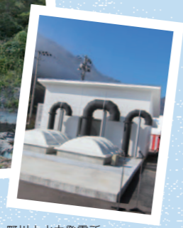
野川小水力発電所
