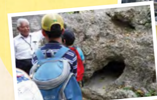
銃撃の激しさを物語る、コンクリート製のトーチカに残った傷跡
