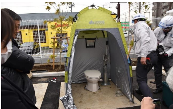
井戸水による災害用水洗トイレ
